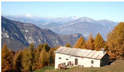
Tetto in pietra in una malga dell'alta Lessinia
