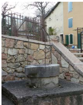
Pozzo in monoblocco di pietra e cisterna sottostante con pareti in pietra
