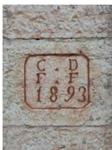
Il millesimo indica la data di costruzione di questa casa
