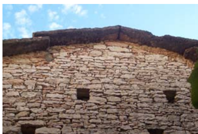
Particolare del fienile con bòcaroi quadrati
