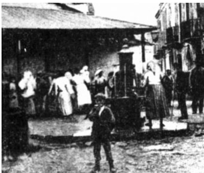
La tettoia per la "vendita del pesce e verdure" costruita in Piazza del Popolo nel luglio 1911 da mastro Antonino Mosca.
