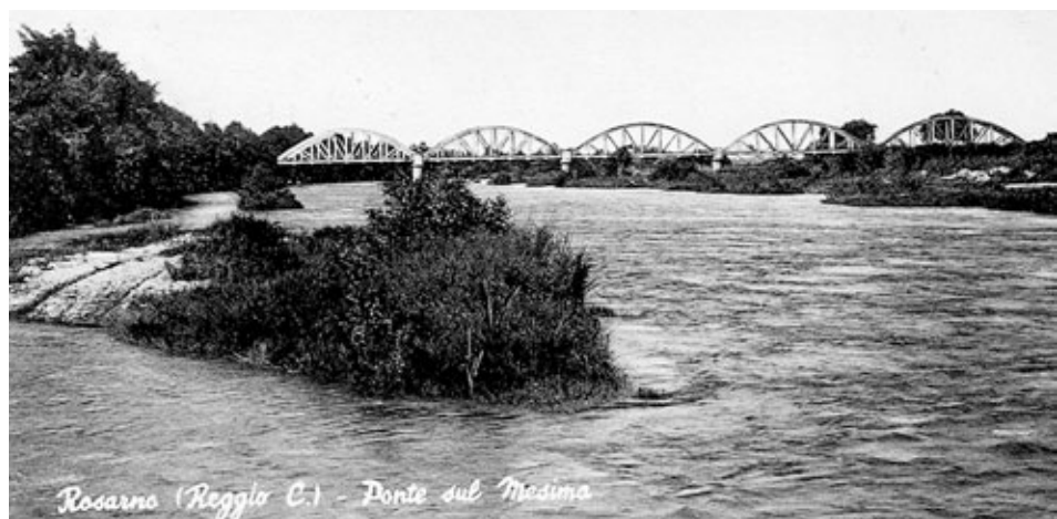
Il ponte sul fiume Mesima costruito nel contesto dei lavori di Bonifica degli anni Trenta.
