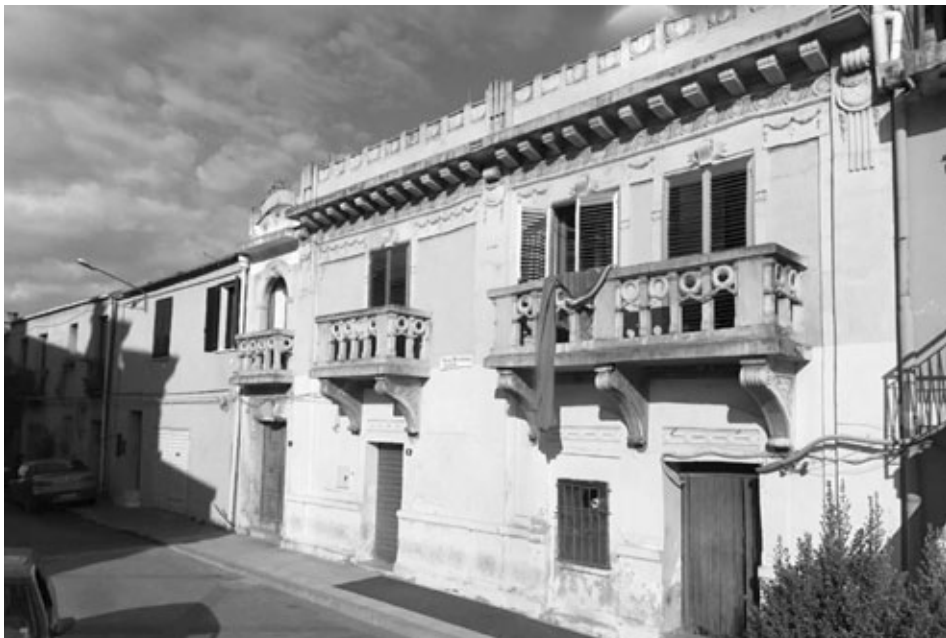
Il palazzo fatto edificare dai Pignatelli, Signori di Rosarno e Duchi di Monteleone, venne distrutto dal terremoto del 1783 e riedificato sullo stesso sito dirimpetto alla facciata centrale della Chiesa Matrice.
