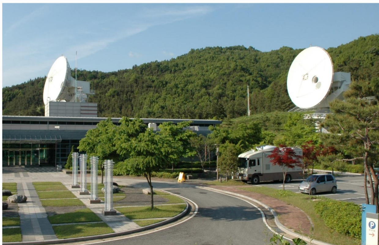
FIGURA 7 Antenas 1 y 2 del SRMC
