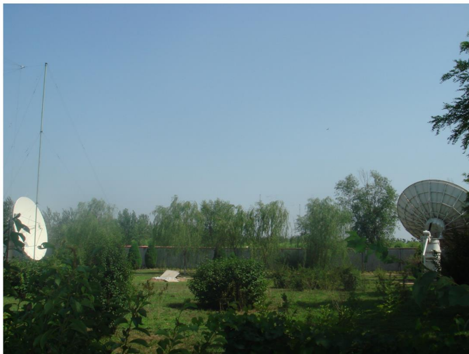
FIGURA 3 Dos antenas de reserva de 7,3 m
