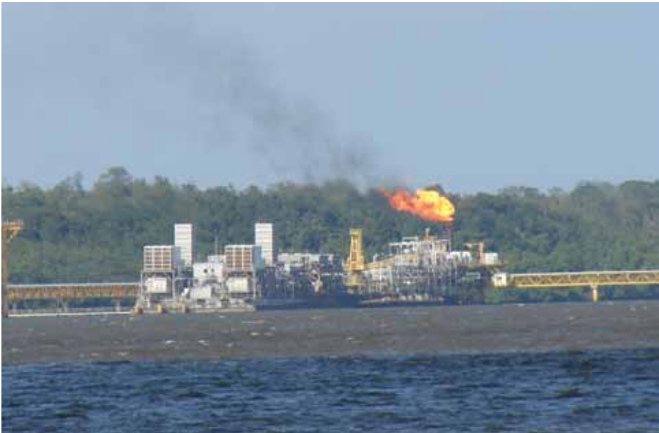
Figura 291. Plataforma petrolera ubicada en el caño Pedernales, delta del Orinoco.
