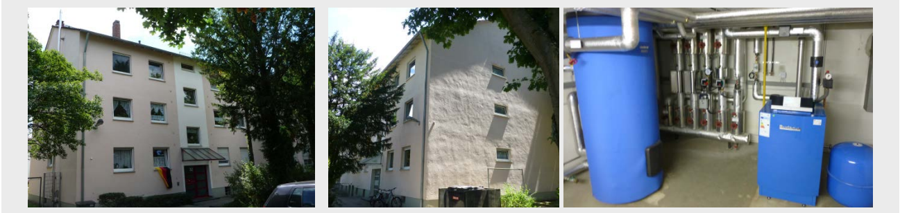
Bild 12: Gebäude und Wärmeversorgungsanlage 500-H109
