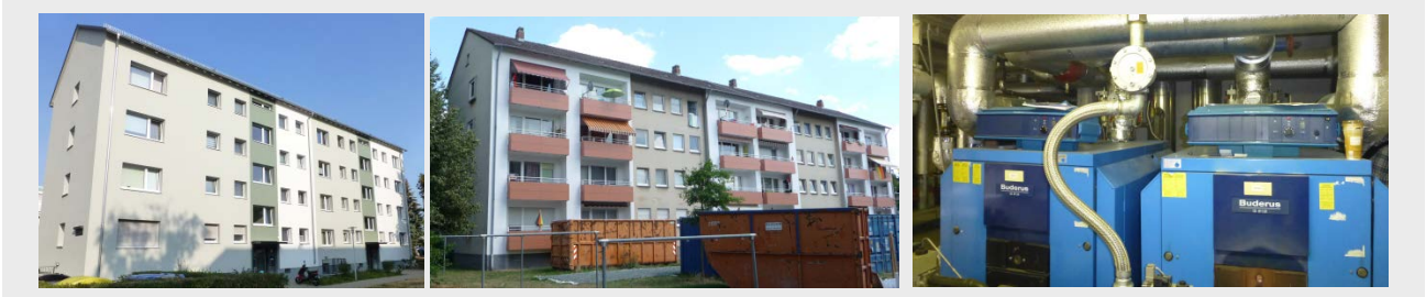
Bild 13: Gebäude und Wärmeversorgungsanlage 500-H105
