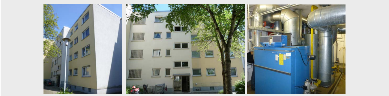
Bild 10: Gebäude und Wärmeversorgungsanlage 500-H69
