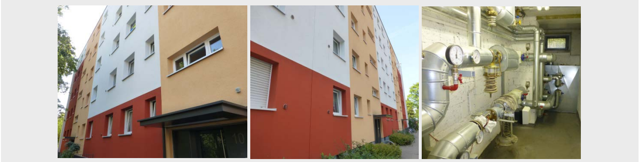
Bild 15: Gebäude und Wärmeversorgungsanlage 500-H2
