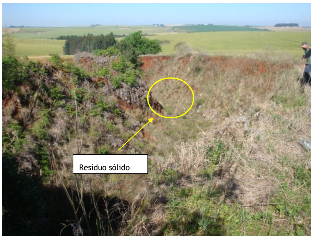
Foto: área em estado avançado de erosão, voçoroca, com depósito irregular de resíduos sólidos. Fonte: Latus Consultoria, 2014.
