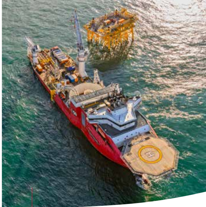
Kabelinstallatieschip Connector sloot de kabels aan op het onderstation 'Noord' op zo'n 34 km voor de kust.
