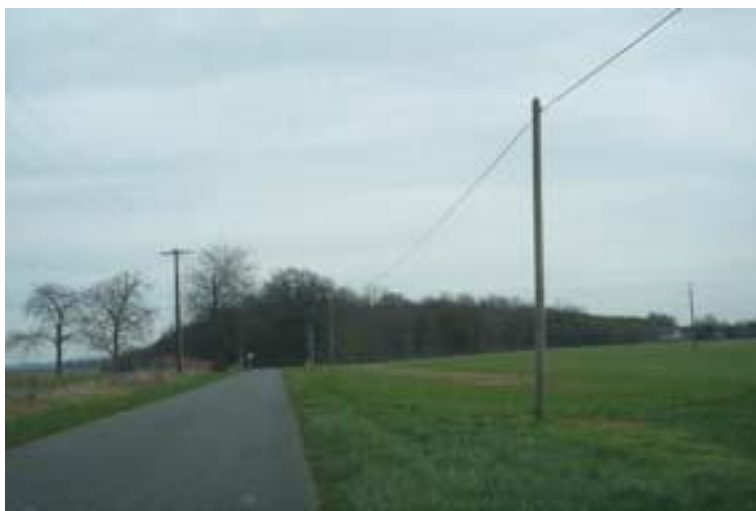
Vue du parc depuis la route D36 au sud-ouest
