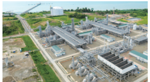
JGC constructed this LNG plant at the Tangguh LNG project in Indonesia
