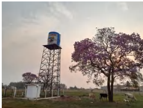
Sistema de Agua Paso Barreto Fuente: Registro fotográfico de trabajo de campo. Equipo consultor. Concepción. Agosto -Septiembre 2020.
