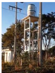
Sistema de Agua Huguá Po'í
