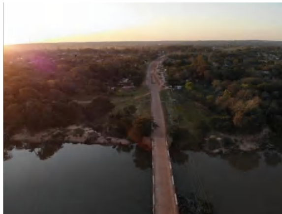
Fuente: Registro fotográfico de trabajo de campo. Equipo consultor. Concepción. Agosto -Septiembre 2020.
