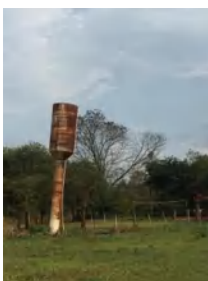
Sistema de Agua Tercera Zona - Huguá Guazú
