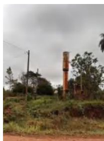
Sistema de Agua Santísima Trinidad
