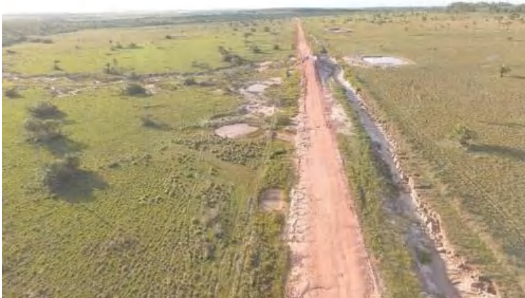
El camino que une a la comunidad con el km 70 de la ruta 5 Bernardino Caballero tiene una longitud de 120 km. Concepción Noticias (2017) 16
