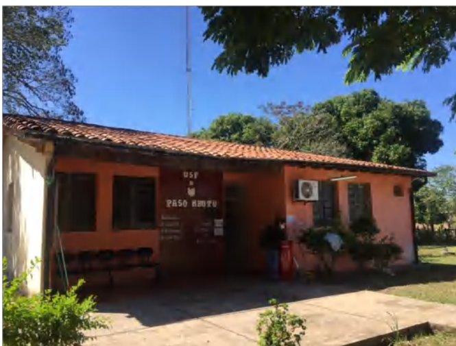
USF Paso Mbutu- Fuente: Registro fotográfico de trabajo de campo. Equipo consultor. Concepción. Agosto -septiembre 2020
