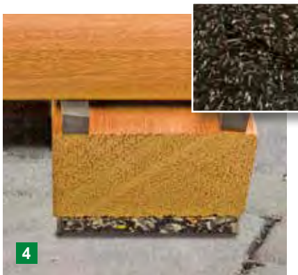
Gummi reguliert: Höhenausgleich-Pads für die Unterkonstruktion.
