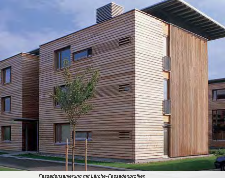
Fassadenanierung mit Lärche-Fassadenprofilen
