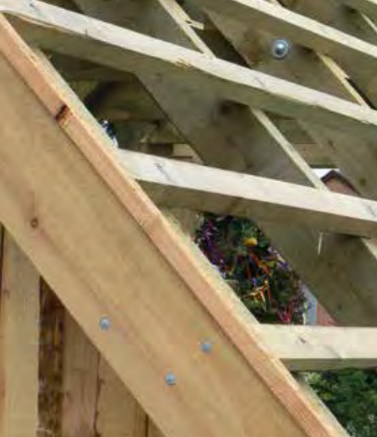
Lärche – Dachstuhl im Detail
