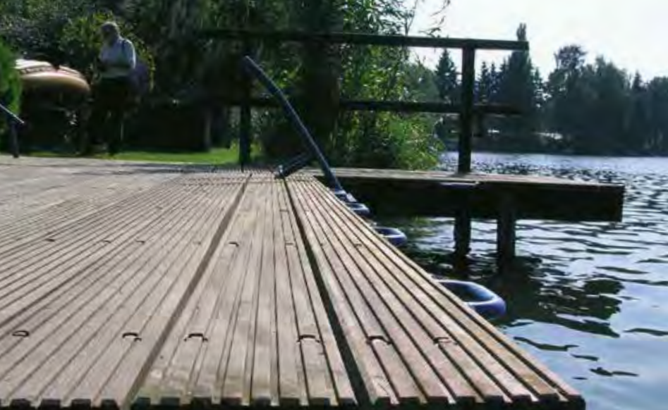
Unterkonstruktion im Wasser: Anwendungsbeispiel für Bongossi-Kantholz
