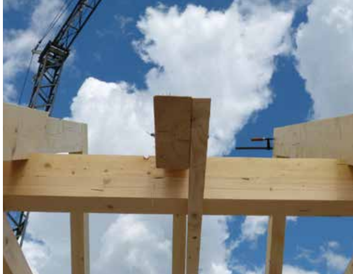
Ein Dachstuhl entsteht: Moderner Holzbau mit dem Naturbaustoff Fichte NSI
