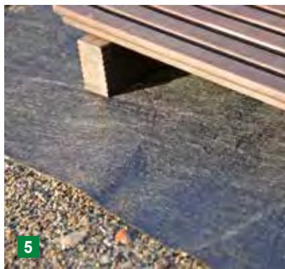
Wasserdurchlässiges Abdeckvlies gegen Durchwurzelung u. Pfützenbildung.
