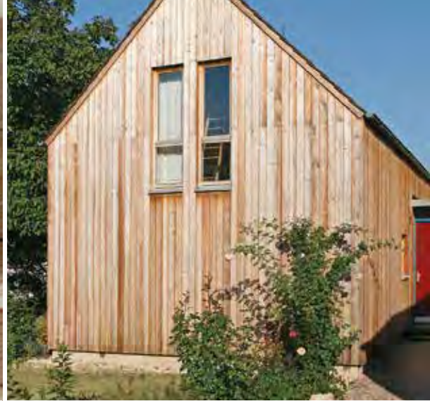
Moderne Fassadengestaltung mit Lärchenholz
