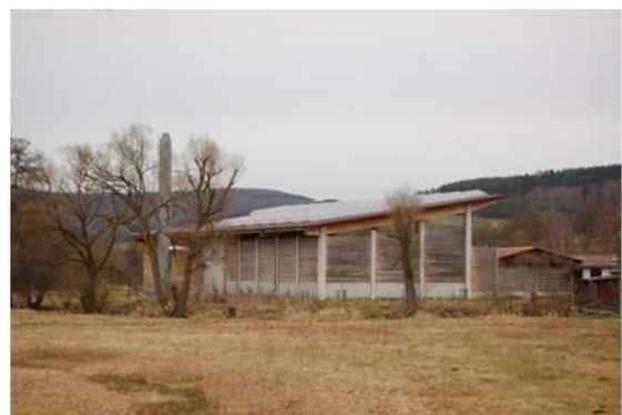
Abbildung 70: Holz hackschnitzel-Heizanlage in Burgjoß, Quelle: Eigene Aufnahme
