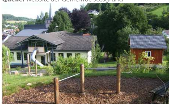
Abbildung 47: Kindergarten Spessartwichtel, Pfaffenhausen,
