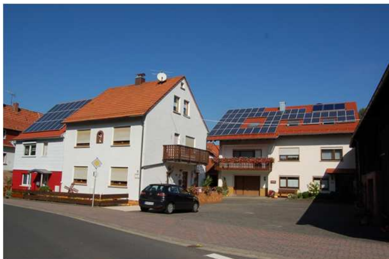
Abbildung 71: Photovoltaikanlagen auf einem Wohnhaus in Pfaffenhausen, Quelle: Eigene Aufnahme
