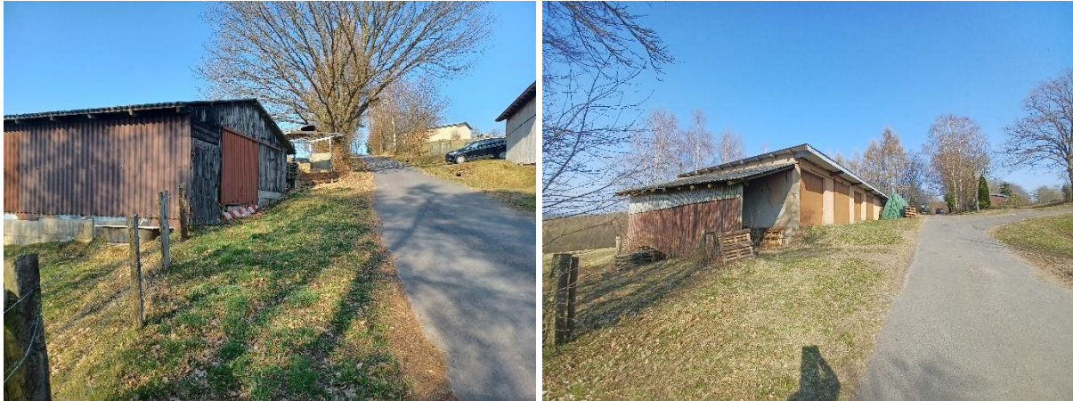
Abb. 7: Scheunengebäude südlich und südwestlich des Plangebiets – Quelle: Eigene Aufnahme
