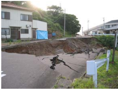
(a)路面崩落状況
