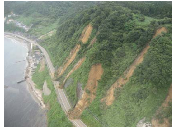
図-112 崩壊による国道の被災状況
