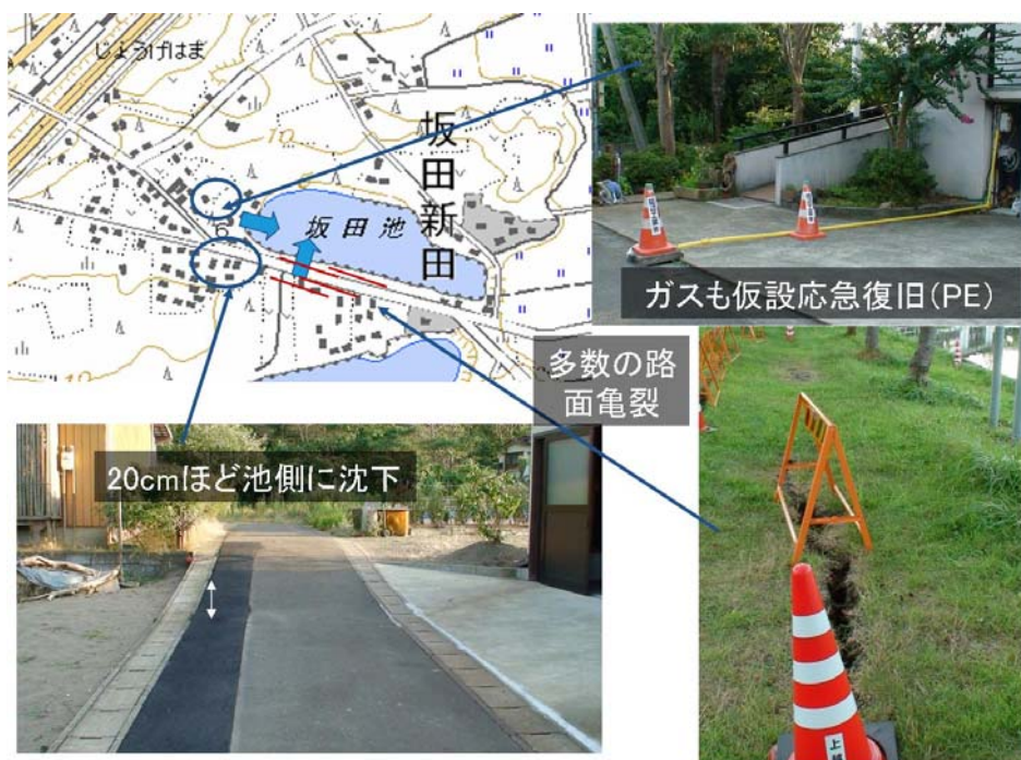
図-74 坂田新田周辺の管路被害
