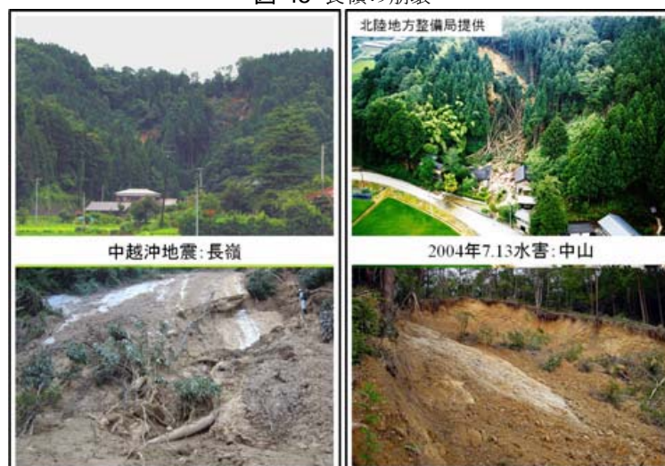
図-46 長嶺の崩壊と類似の崩壊
