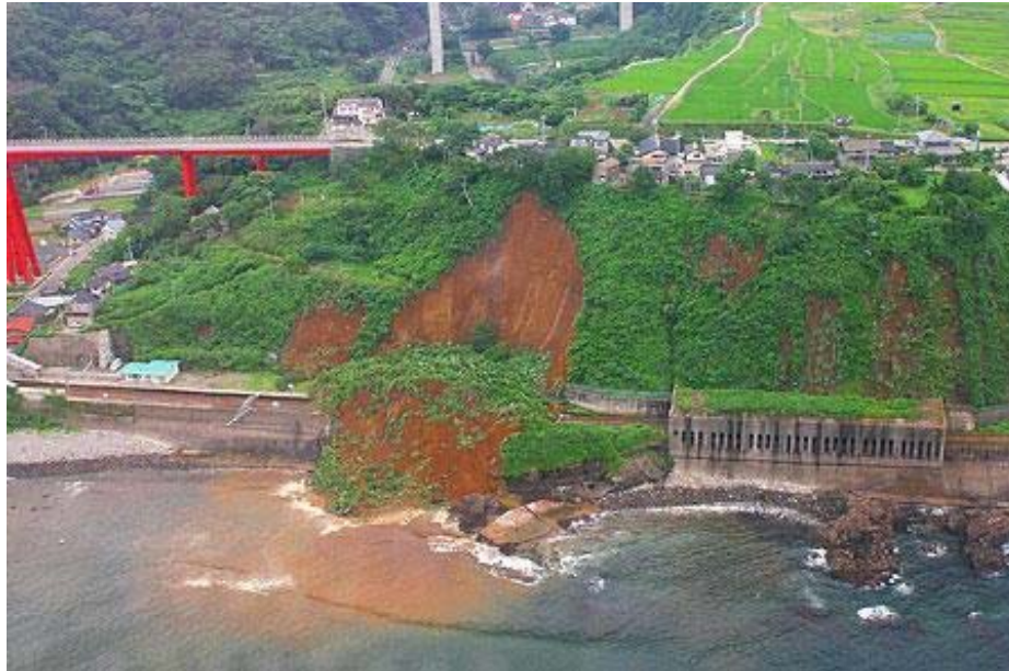
図-117 青海川駅構内の斜面崩壊
