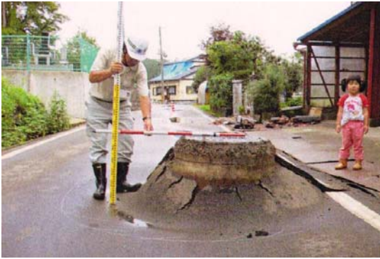
図-80 マンホールの浮上 (柏崎市ガス水道局)
