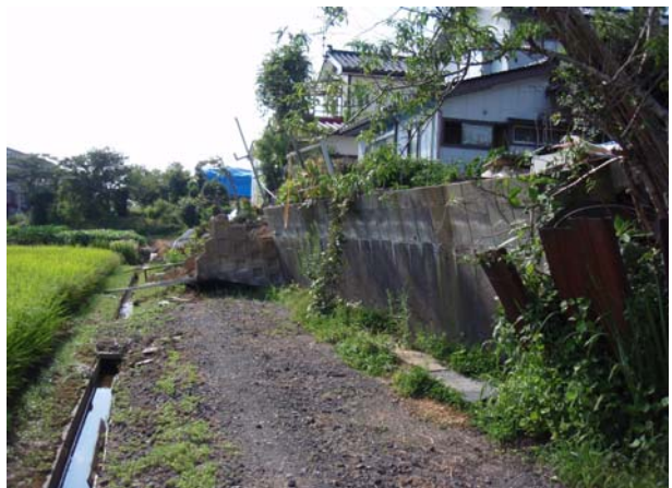
図-138 盛土部分の滑動による擁壁の転倒・倒壊 (茨目団地)
