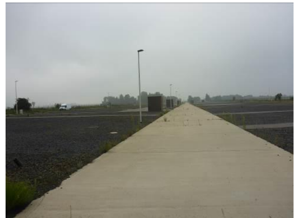
Abbildung 14: Versiegelte und teilversiegelte Flächen der ehemaligen Antennenanlage.
