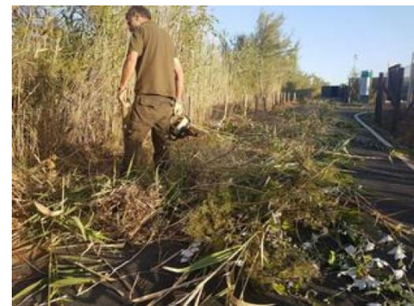
Labores de mantenimiento de infraestructuras.
