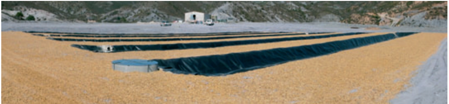
Filtro en construcción para la cooperativa porcina Gamur
