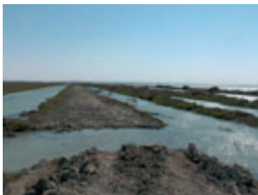
Rebaje de muros en el interior de la salina del Consulado
