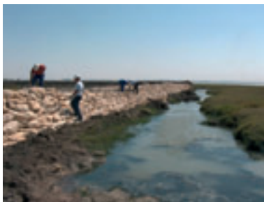
Colocación manual de escollera en la salina del Consulado
