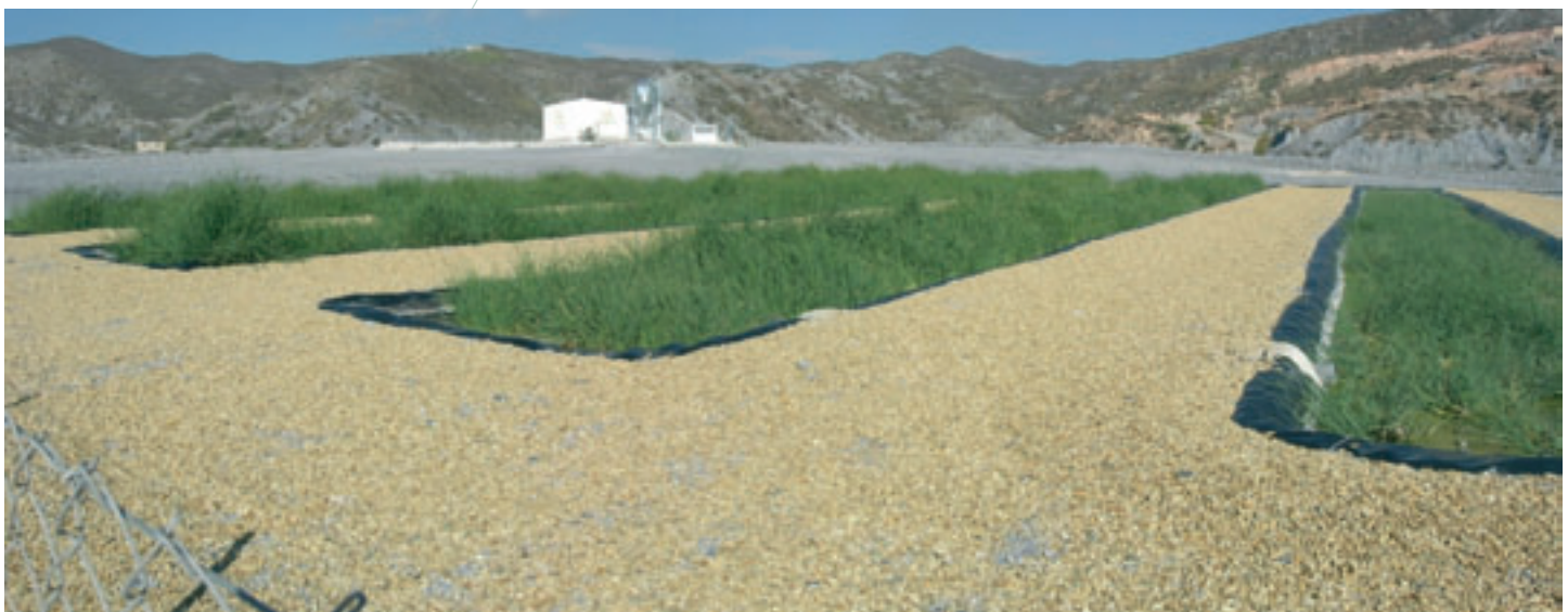
Vista panorámica del filtro de macrófitas de la cooperativa de Gamur
