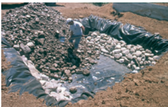
Construcción de humedal artificial
