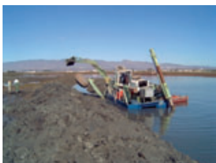
Restauración de dique salinero
