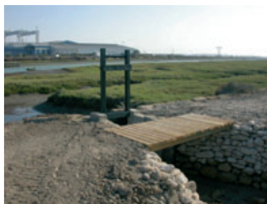
Compuerta restaurada en la salina del Consulado
