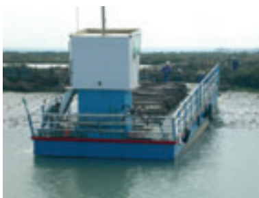
Barcaza utilizada en el transporte de materiales y maquinaria
