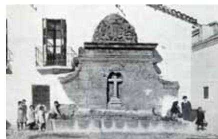
Ejemplos de fuentes con pilastra y con frontón, en este caso adosado a un edificio: fuente de Archidona (Málaga) y antigua fuente del Pilar de la Placeta de Iznalloz (Granada), en imágenes del Portfolio fotográfico de España . [CONSEJERÍA DE MEDIO AMBIENTE, JUNTA DE ANDALUCÍA]
