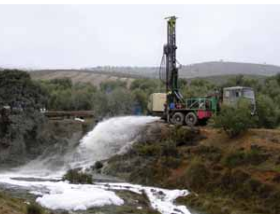
Máquina de rotoperación perforando materiales acuíferos de las Cordilleras Béticas. [A. CASTILLO]
