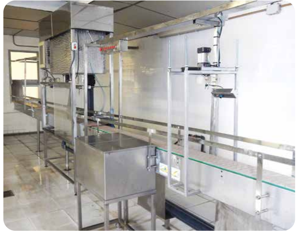
Línea de llenado de envases y dispositivo de control de cantidad en la sala limpia de Sierra Bonela.
