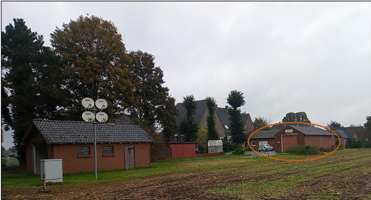
Abbildung 3: Gelände des bisherigen Feuerwehrstandortes „Emmericher Eyland“
