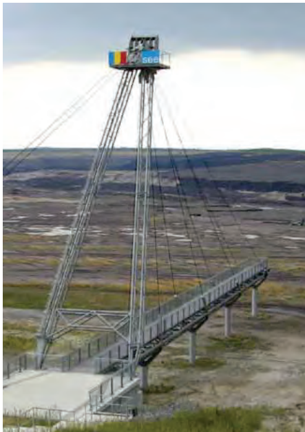
Zukunftsweisende bauliche Elemente
