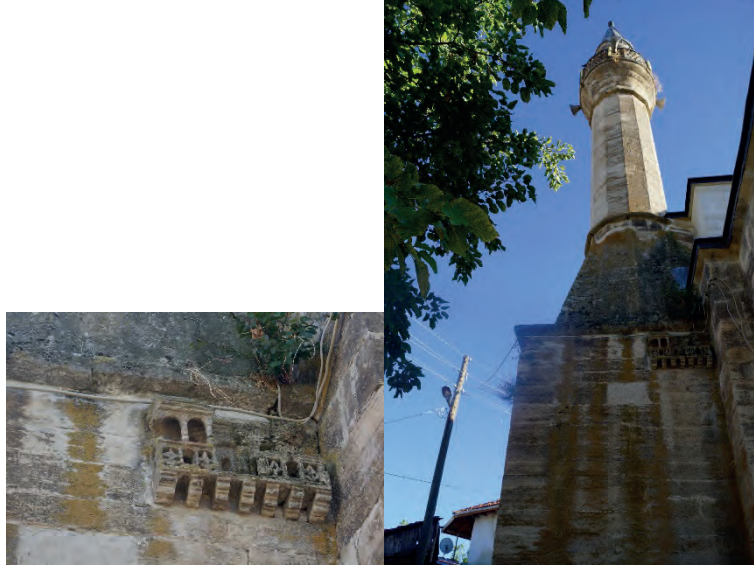
Şekil 110 Çalçı Köyü Camii, Mihaliççık (TÜBİTAK Eskişehir Dil Atlası Projesi'nden)
