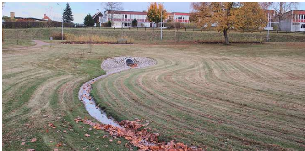
Figur 19 Exempelbild av torrdamm (foto: Stockholm Vatten och Avfall)
