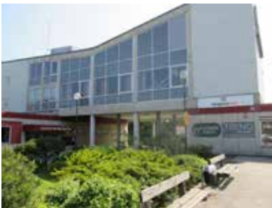
Medborgarhuset har idag igensatta fönsterpartier både på den högre delen och på lågdelarna.
