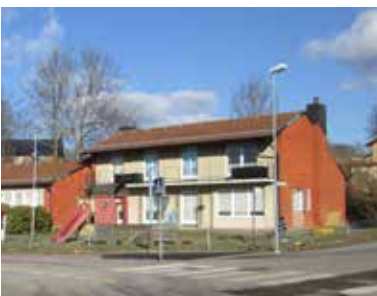
Bebyggelse på fastigheten Syrenen 4 längs Augerumsvägen
