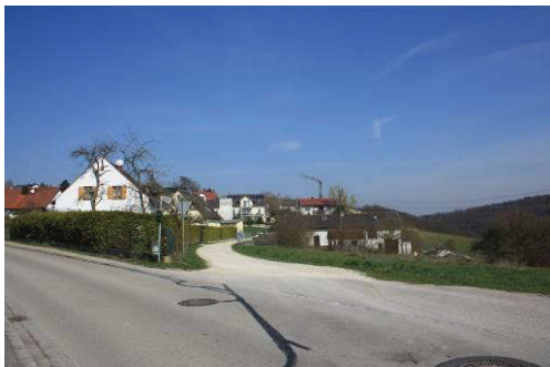
„Fliederweg“ von rechts her in die weiter gerade verlaufende Erschließungsstraße „Gstaigkircherl“
