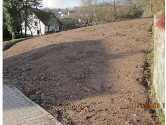
Grundstück der ehem. Grundschule mit Kindergarten in Hoof (Kreisstadt St. Wendel) nach dem Abriss, Dezember 2018
