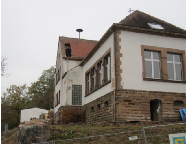
Ehem. Grundschule mit Kindergarten in Hoof (Kreisstadt St. Wendel vor dem Abriss (November 2018)
