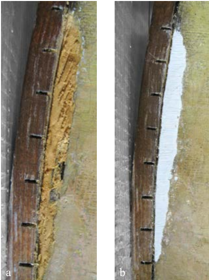
Abb. 56: a. 10 mm breite Holzleiste im Randbereich und Füllung der holzwurmgeschädigten Bereiche mit alten Fichtenholzfasern und Holzkitt. b. Detail nach der Kittung der Fehlstelle.
