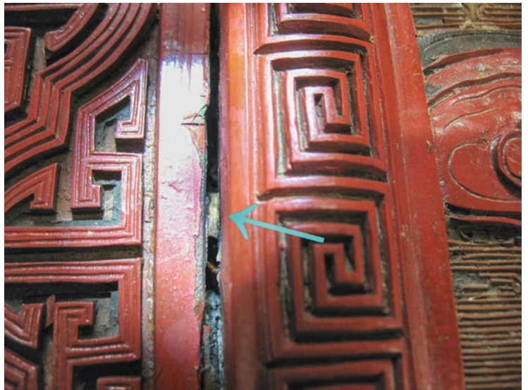
Abb. 17: Bambusdübel zwischen Füllung und Rahmen.
