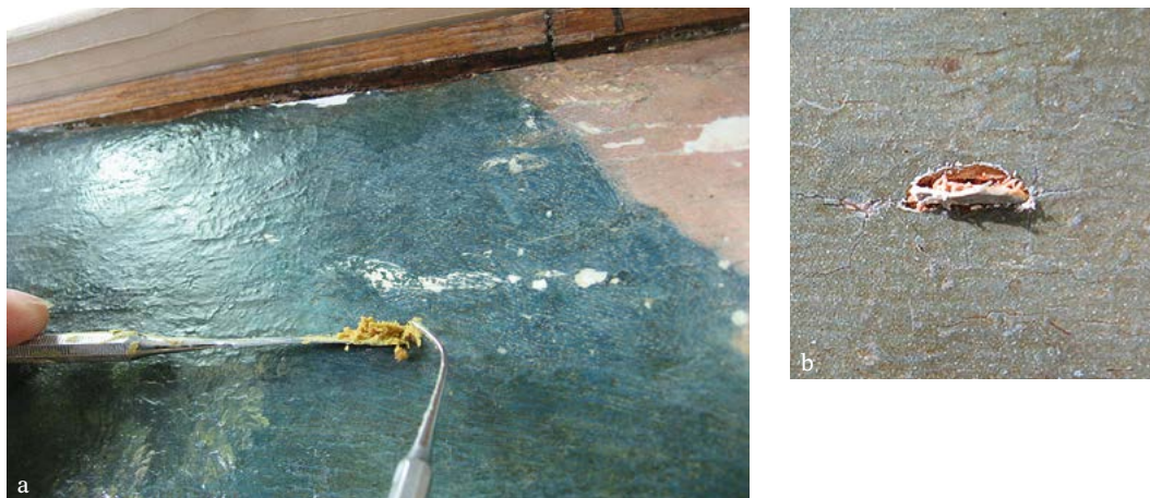
Abb. 53: a. Die Holzwurmlöcher wurden gefestigt und mit Holzkitt gefüllt. b. Detail einer Malschichtabhebung aufgrund des Holzwurmbefalls.
