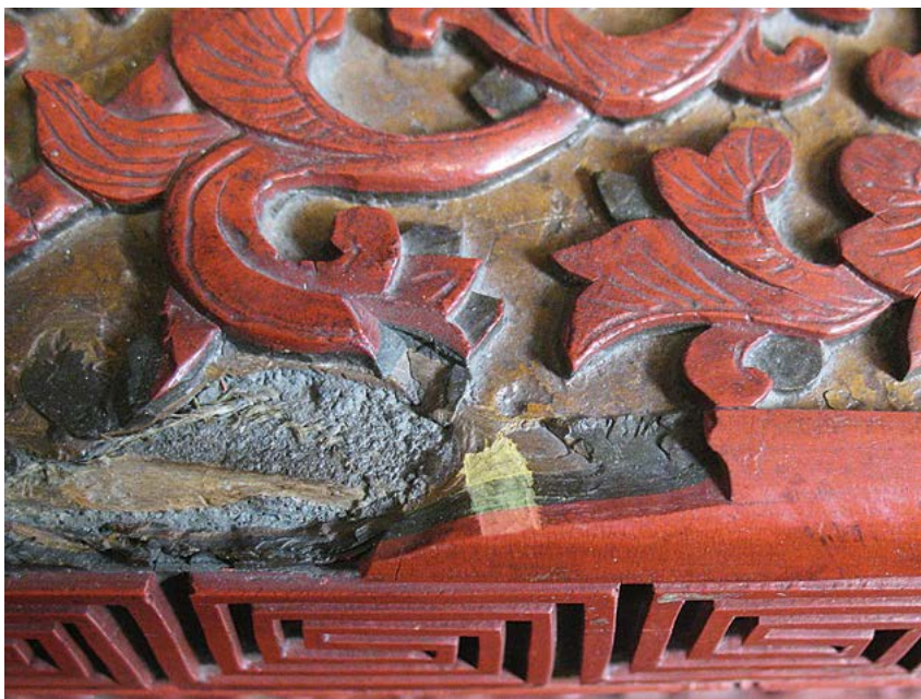
Abb. 23: Ausbruch an der Sockelkante vorne: Durch Abschaben der obersten Schmutz- und Oxidationsschicht ist die originale Farbigkeit erkennbar.
