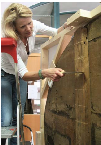
Abb. 50: Detail der oberen Gratleiste: Die Einschnitte wurden mit einer japanischen Säge ausgeführt.
