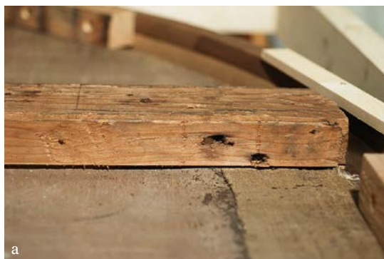
Abb. 41: a. Detail der oberen ergänzten Gratleiste. b. Seitenansicht der Gratleiste an der rechten Seitenkante (waagrecht verlaufende Jahrringe). c. Seitenansicht der unteren originalen Gratleiste an der rechten Seitenkante (senkrecht verlaufende Jahrringe).
