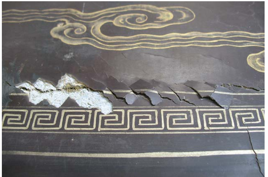
Abb. 44: Aufstehende Lackschollen entlang einer Konstruktionsfuge, Rückseite.
