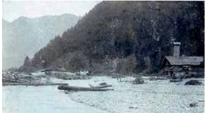
Die Kohlstatt nach dem Dammbbruch vom 13. September 1899.
