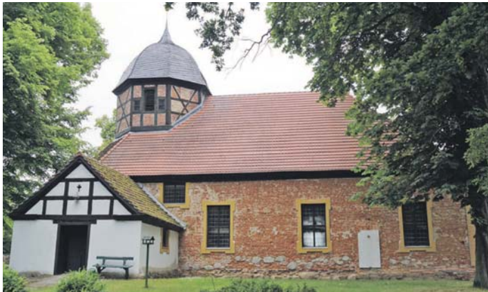
Die Trinitatiskirche in Ferdinandshof bei Torgelow ist seit Monaten eine Baustelle.
