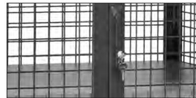
Treibriegelverschluss mit Schwenkhebel und Zylinderschloss.
