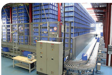
Automatisches Kleinteilelager/automatic small-parts warehouse in Eggenfelden, Oktober 2003
