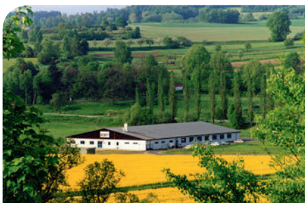
Neubau des Werks in Čkyně (CZ), Mai 1998 New building of the plant in Čkyně (CZ), May 1998
