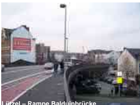
Lützel – Rampe Balduinbrücke
