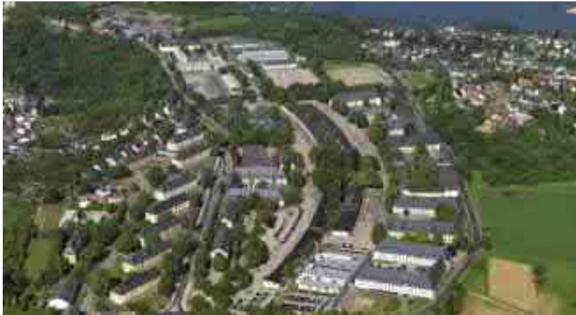
Blick von Osten über die Fritsch-Kaserne
