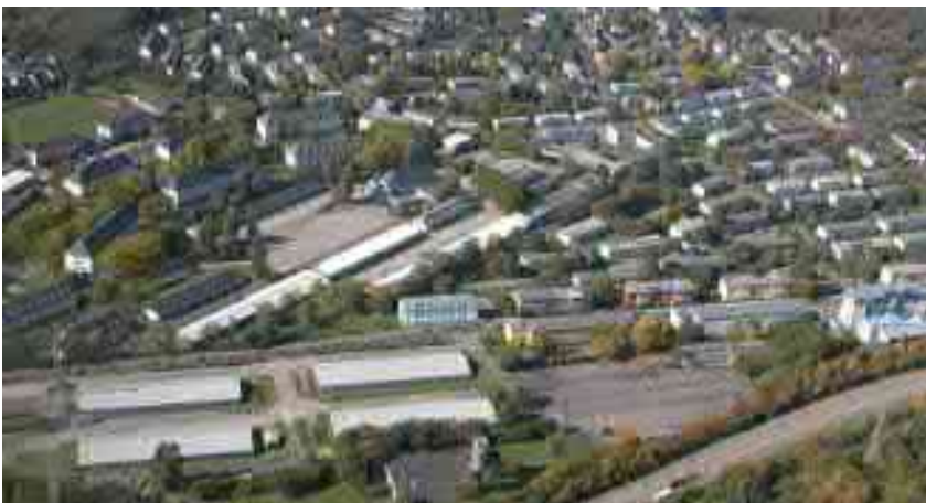
Blick von Norden über die Pfaffendorfer Höhe und Horchheimer Höhe
