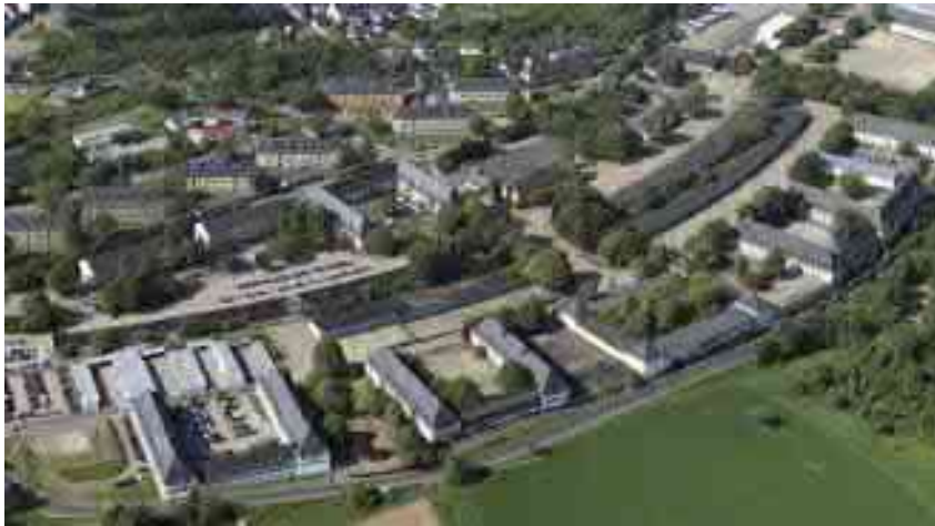
Blick von Norden über die Fritsch-Kaserne in Koblenz-Niederberg
