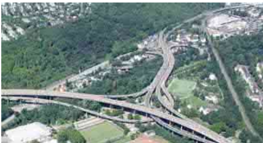
Blick von Südosten über den „ Stadteingang Süd “
