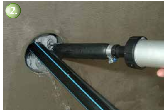
2. Das Material wird mit der KÖSTER Hand-Pistole in den Raum zwischen Kabel und Wand gepresst und das Wasser dauerhaft gestoppt
