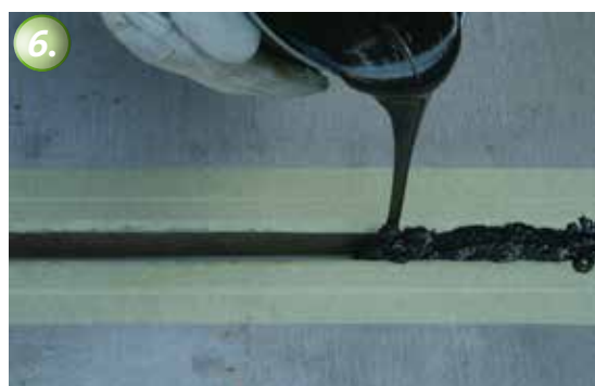
6. Das Verfüllen der Fuge erfolgt ca. 2 Stunden nach Aufbringen von KÖSTER FS-Primer 2K.
