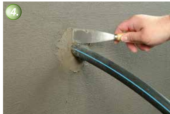
4. Die Kabeldurchführung ist nun dauerhaft abgedichtet.
