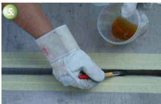
5. Saugfähige Untergründe sind mit KÖSTER FS-Primer 2K zweimal zu grundieren, nicht saugende Untergründe müssen mit KÖSTER FS-Primer 2K einmal vorgestrichen werden.
