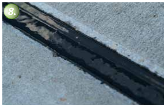
8. KÖSTER Fugenspachtel FS-H im ausreagierten Zustand.
