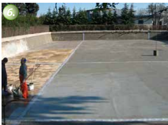
6. Auf die Abdichtung können die Fliesen mit herkömmlichem Fliesenkleber aufgebracht werden.
