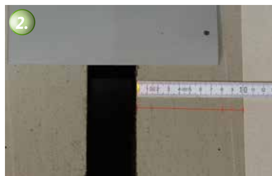
2. Das KÖSTER Fugenband 20 mind. 4 cm, das KÖSTER Fugenband 30 mind. 5 cm breit in den KÖSTER KB-Pox Kleber einbetten. Der Kleber wird ca. 2cm breiter als die Bandbreite aufgebracht.
