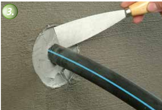
3. Um die Abdichtung zu schützen, wird die Fläche geglättet und mit KÖSTER KB-FIX 5 verspachtelt.
