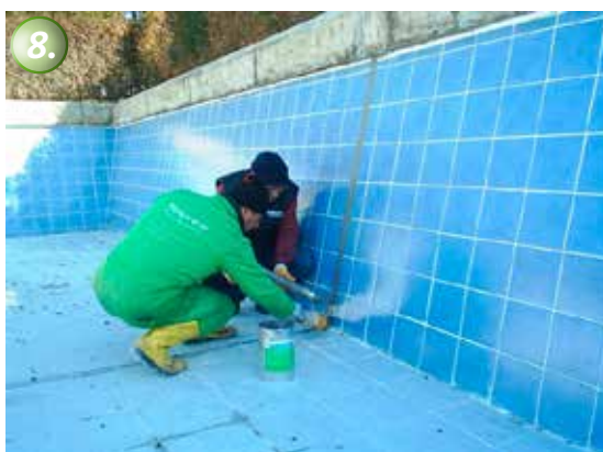
8. Die horizontalen Fugen werden mit dem selbstverlaufenden KÖSTER Fugenspachtel FS-H abgedichtet. Der standfeste KÖSTER Fugenspachtel FS-V wird für die Abdichtung der vertikalen Fugen eingesetzt.
