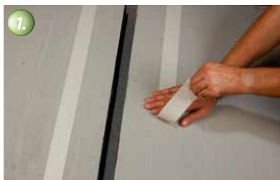
1. Beide Seiten der Fuge werden mit Klebeband abgeklebt.
