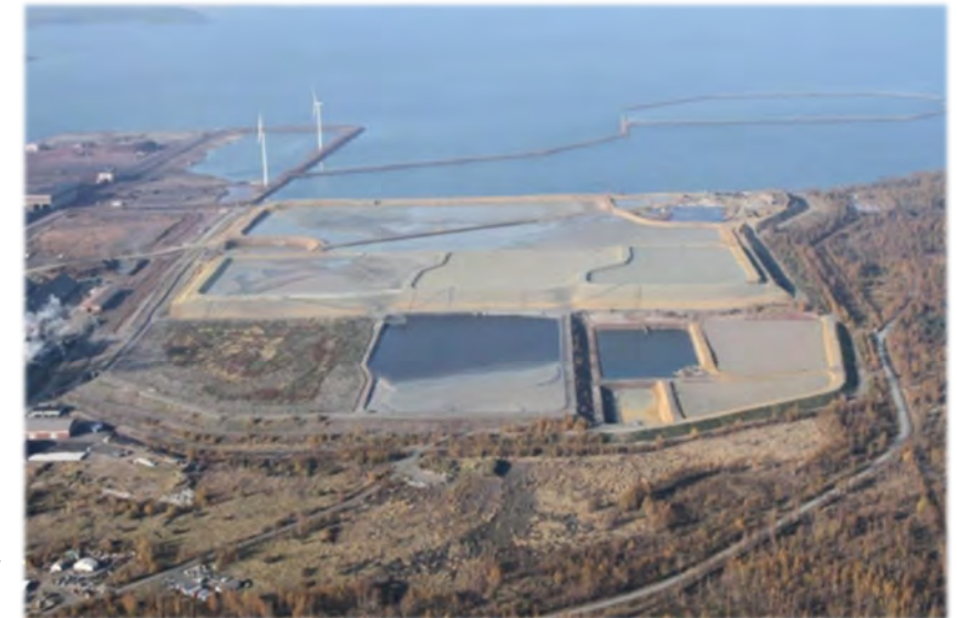
Soptipp för farligt avfall, Boliden
