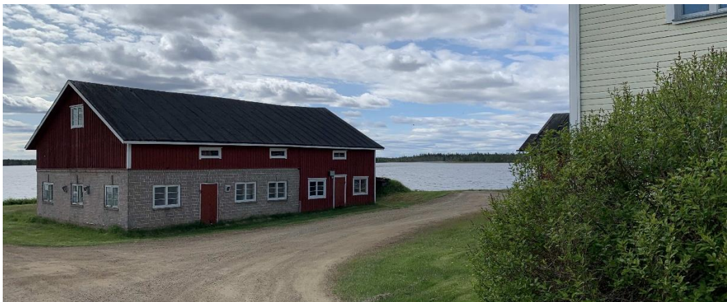
Kuva 58. Ylläsjärven navetta ja asuinrakennukset.
