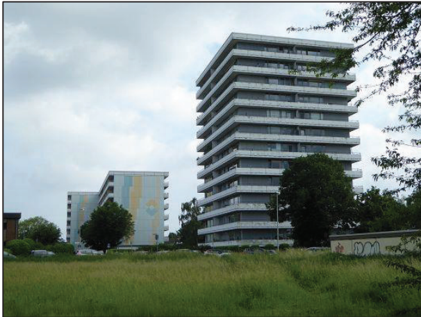
Foto 1: Der hohe Wohnhauskomplex in der Mitte des Gebietes sticht aus der umliegenden Wohnbebauung mit Einfamilienhäusern heraus.
