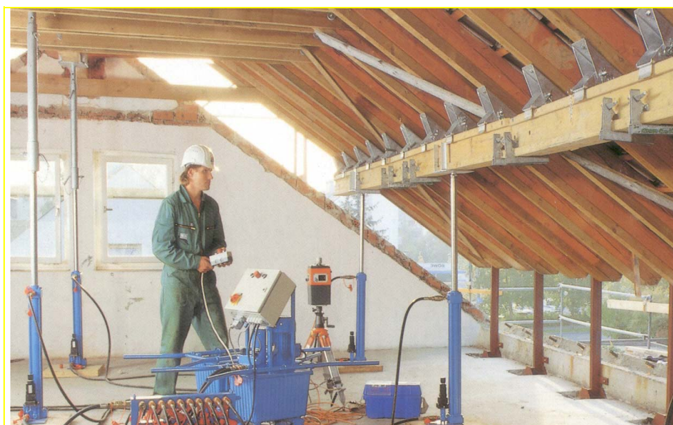
Abb. 6.10-21: Anhebung eines Dachstuhls mit Hydraulikstempeln (Dino, Dachhebesystem)
