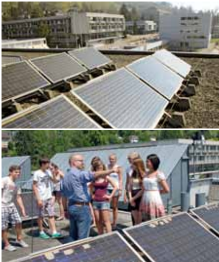
Die Rysolar-Anlage mit den Gebäuden, auf denen die neue Anlage entsteht.
