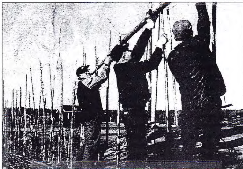
Figur 41. Iläggning av gärdsel i långlagd gärdesgård. Husby-Långhundra bygdegård Blå Wingen ca 1,5 mil fågelvägen SO om Uppsala. Bilden införd i Uppsala Nya Tidning, UNT, 98.11.04.
