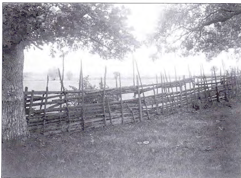
Figur 45. Överstörad gårdsgård. Lägg märke till hur gårdslena har sjunkit i konstruktionen samt att stöd inte har kommit till användning. E.U. 8508, Skånings-Åsaka socken och Skåningshärad i Västergötland. Neg. nr. 259. S. p. Fotot taget av R. Odencrants 1/9 1934.
