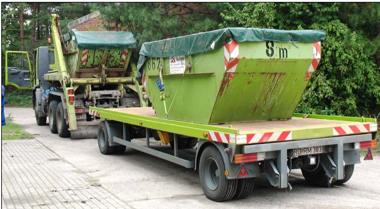
Bild 4: Anlieferung der Geschiebemergel-Container bei der BAW
