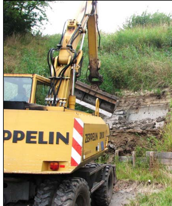
Bild 3: Baggerung des Geschiebemergels
