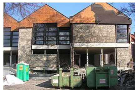
Klinker und Eternitschiefer ade: An der Fassade ist schon intensiv geknabbert worden. Foto: Günter Tillack, Kreis Borken
