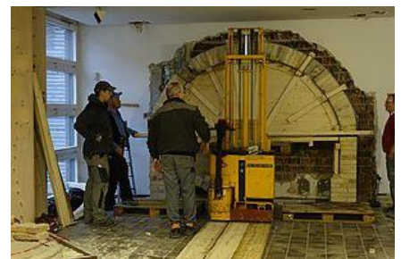
Experten am Werk: Bau eines Lehrgerüsts zur Unterstützung des Bogens. Foto: Martina Volmer, Kreis Borken
