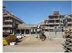
Baustellenansicht. Foto: Kreis Borken.
