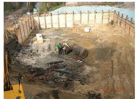
Letzte Absprachen der Experten in der Baugrube für den Beginn der Rohbauarbeiten. Foto: Günter Tillack, Kreis Borken
