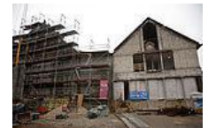
Der Rohbau des Neubaus (links) und das 80er Jahre Bestandsgebäude (rechts). Foto: Lisa Kannenbrock, Kreis Borken
