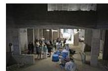
Führung durch den Rohbau des 'kult'. Foto: Kreis Borken.
