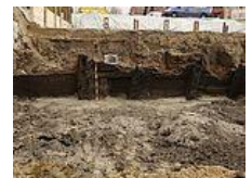
Nordöstlicher Abschnitt der Uferbefestigung aus Eichenholz, dahinter modernes Fundamentmauerwerk. Foto: Uneath
