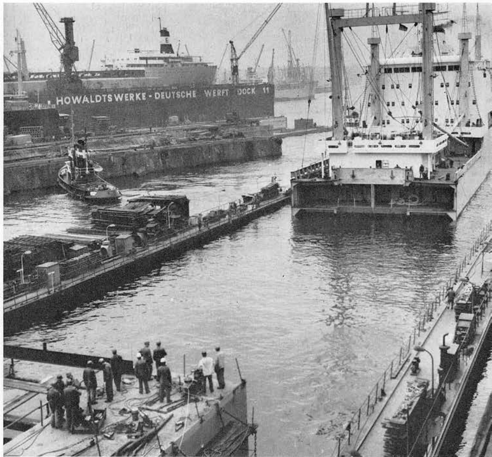
Det Dansk-Franske D/S, Kopenhagen, ließ im Sommer bei uns zwei Schiffe verlängern. In jeweils einem Monat wurden im Werk Ross „Banana“ und „Kinshasa“ durch ein 17,6 m langes, 410 t schweres Zwischenstück um ca. 3500 m 3 vergrößert, wodurch die Ladefähigkeit wirtschaftlicher wurde.
