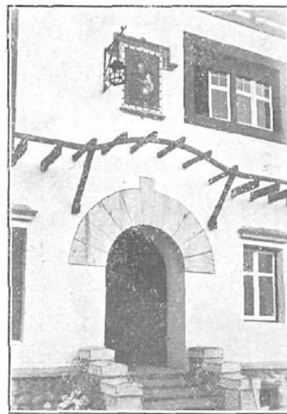
Detalle de la puerta principal.
