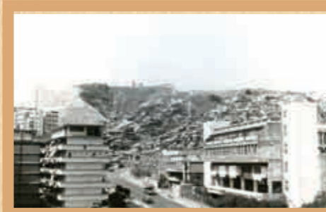
▲ 山坡上滿布僭建木屋
