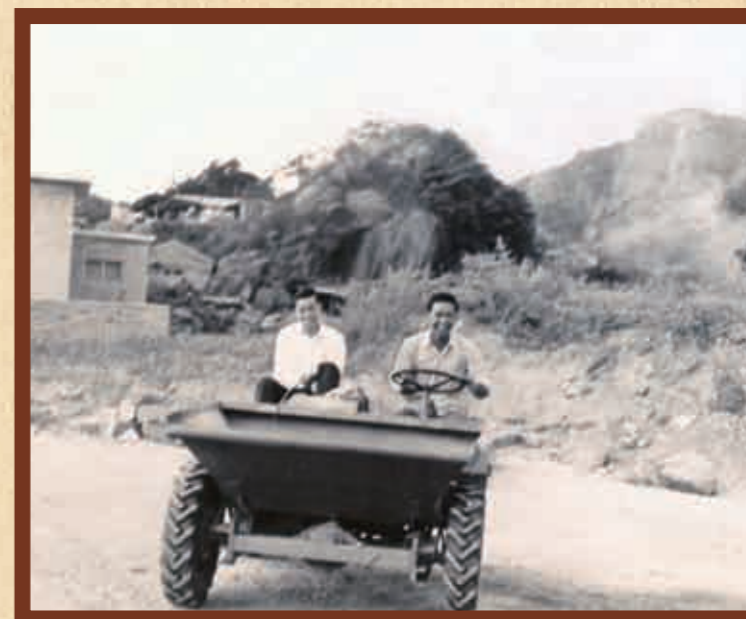
▲ 六十年代初石礦場採用的運石車，載貨斗設於車的前端 (葉栢強先生提供)
