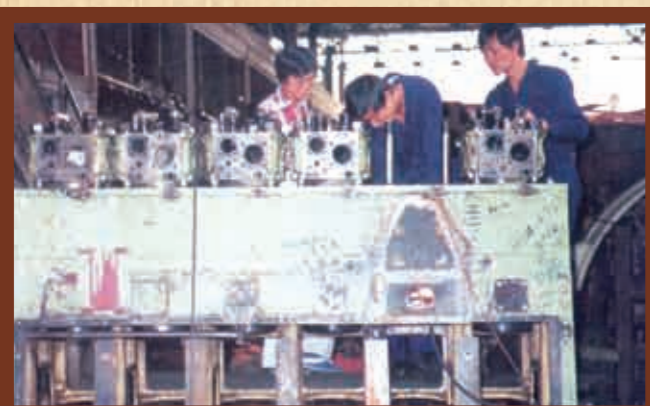
宏德造船廠工人正在維修柴油機座(約1970年代末) ▼
