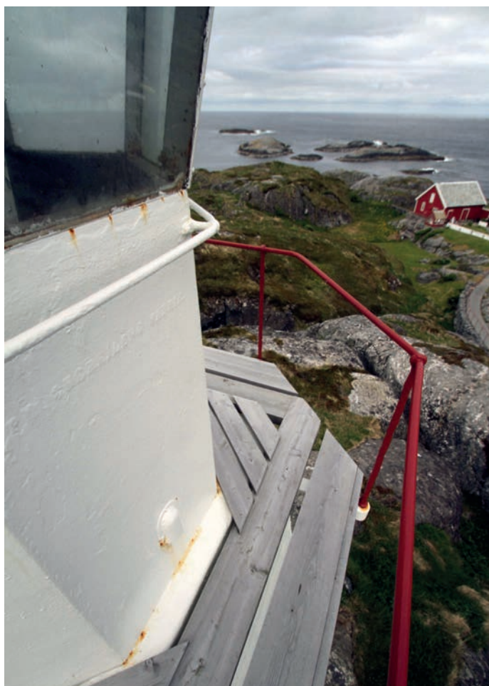
Over: Linsa. Under: Enkelt galleri med enkelt rekkeverk.
