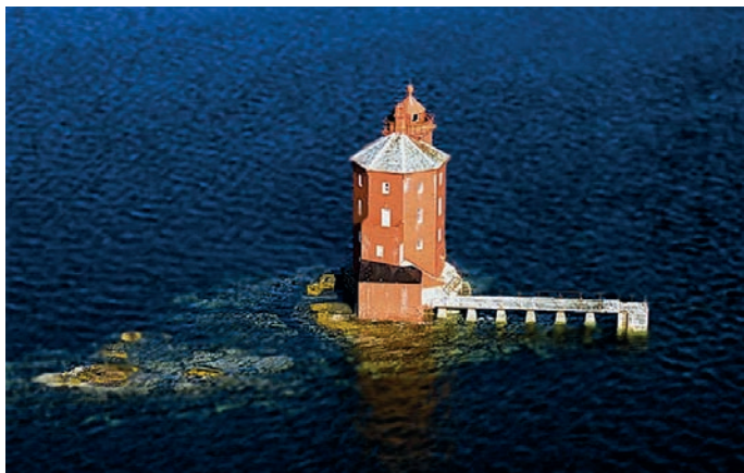
Kjeungskjæret fyrstasjon, Sør-Trøndelag. Foto: Kystverket.
