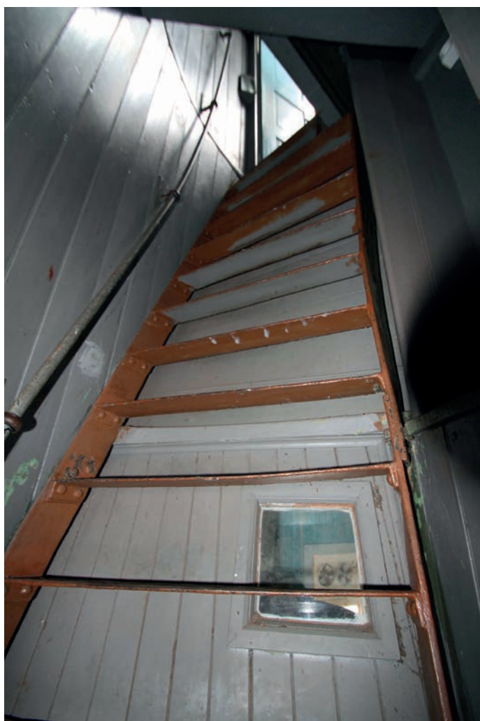
Under: Enkel ståltrapp til fyrlykt.
