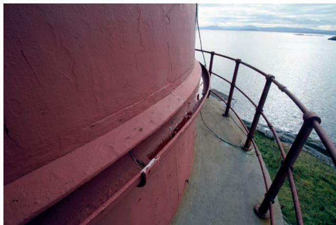
Under: Takrenne langs yttervegg, nedre galleri med rekkverk.
