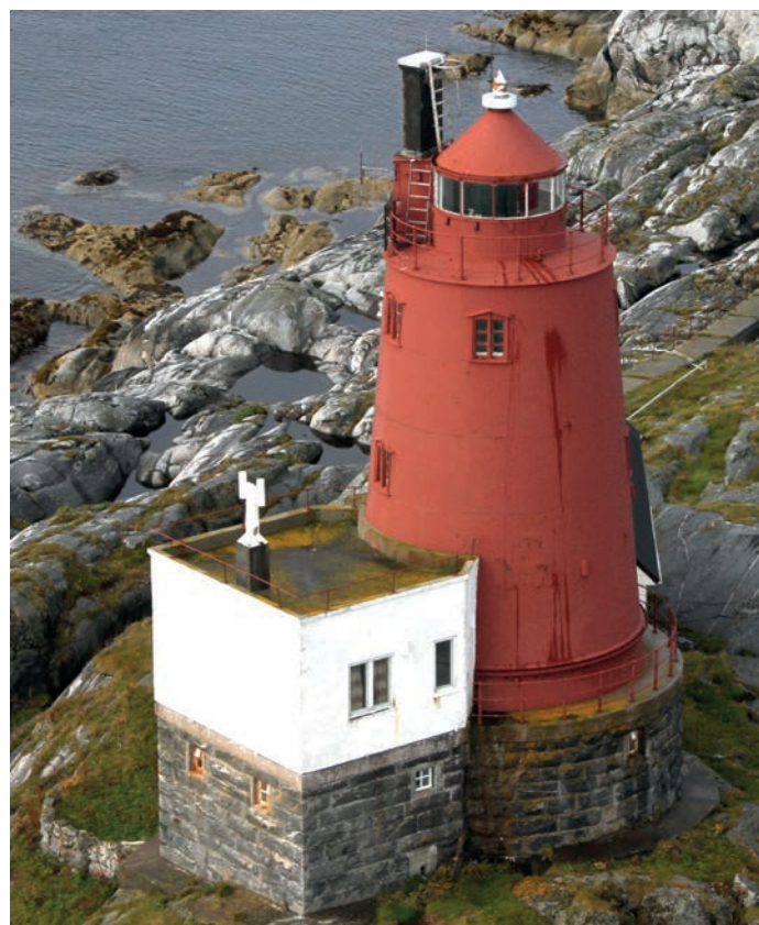
Under: Fyrtårnet og boligen sett fra nordøst.
