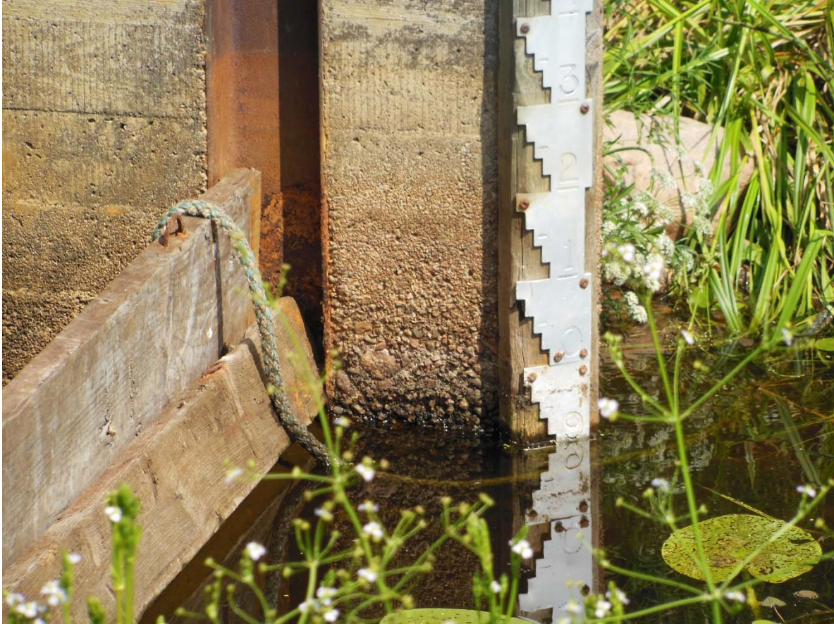
Kuva 3. Onkamaanjärven vedenpinnankorkeuden mitta-asteikko ja lankkupato lasku-uoman ylittävässä sillassa 26.6.2013. Kuvanottohetkellä vedenkorkeus oli N60+26,91.
