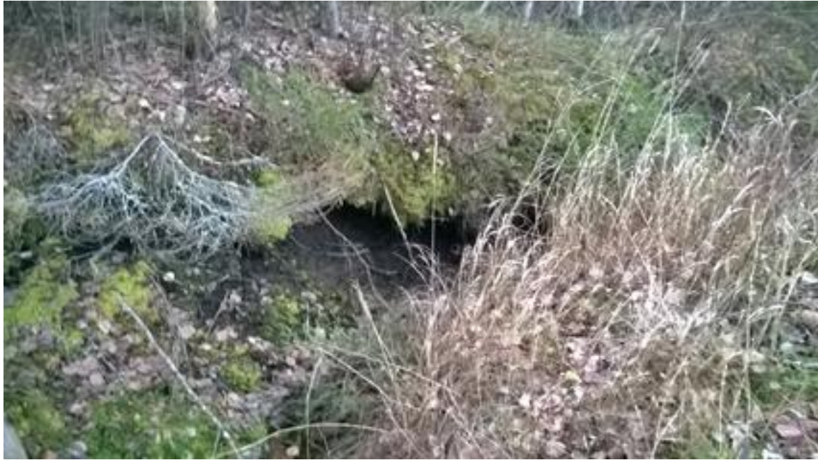
Kuva 3. Palosuolta tuleva oja pellon reunassa. Ojassa näkyy eroosiota.
