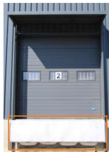
Dämpfungssystem beim Eintreffen der LKWs
