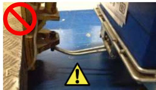
Teleskopkupplung durch festen Haken an der Maschine verbogen.
