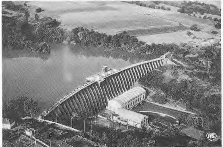
Une œuvre de jeunesse remarquable de hardiesse : le barrage de Vezins, à voûtes multiples, sur la Sélune.
