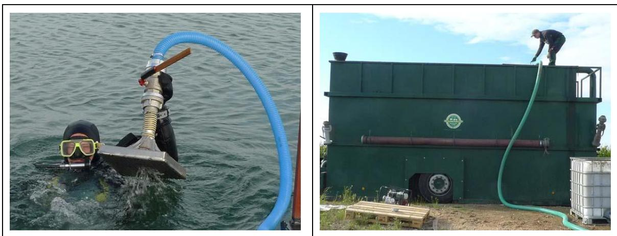
Abb. 3-10, 3-11: Entnahme von Sediment mit Diasporen im Saugverfahren; Transport des Wasser-Sediment-Gemisches in einem Container (Projekt Phoenixsee, VAN DE WEYER et al. 2014)
