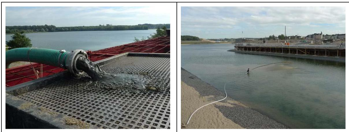
Abb. 3-12, 3-13: Entnahme von Sediment mit Diasporen im Saugverfahren: Filterung des Wassers mit feinen Gitter; Anspritzverfahren (Projekt Phoenixsee, VAN DE WEYER et al. 2014)
